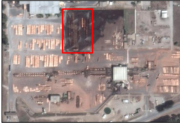
Figura 6.1, Vista área complejo Bosques Arauco, área recepción de trozos.
