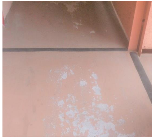
Figura 2: Juntas de dilatación sísmicas.
