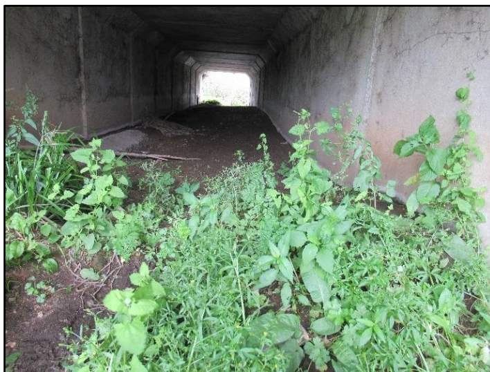
Figura 17. Vano del punto 2
