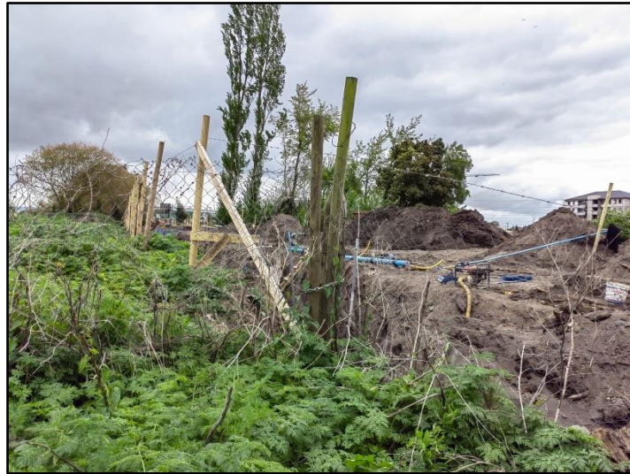
Figura 18. Trabajos realizándose en las cercanías del punto 3.
