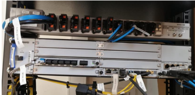
Figura 2.3.1. BBU (Baseband unit). Fuente: Laboratorio 5G UCSC
