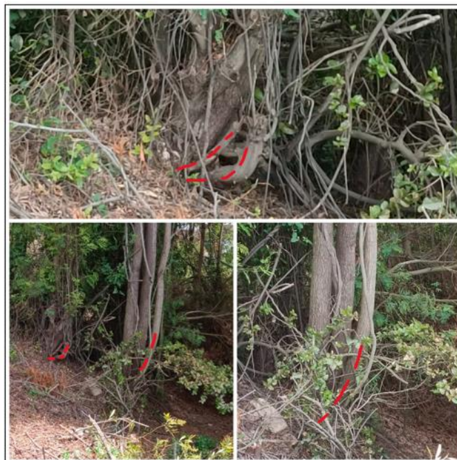
Figura 14: Basculamiento de árboles en el Sector Baños, Escuela F - 490. Elaboración propia.
