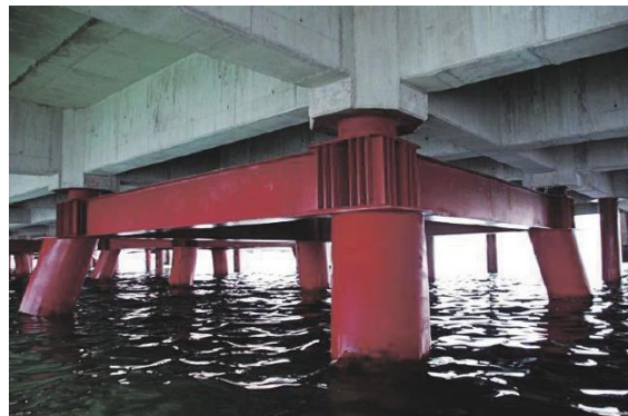
Figura 2. 11: Aisladores sísmicos utilizados en muelle Coronel (www.SIRVE.cl).
