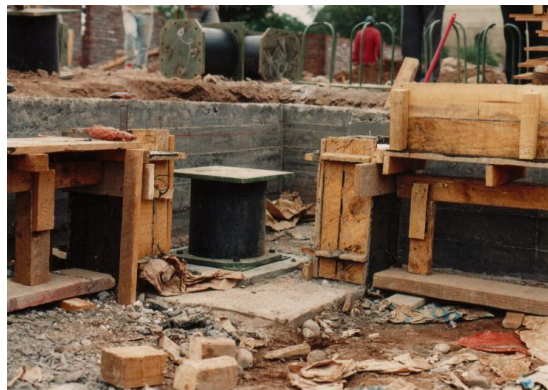
Figura 2. 9: Aisladores sísmicos utilizados en el edificio Andalucía ( http://www.renadic.cl/ ).
