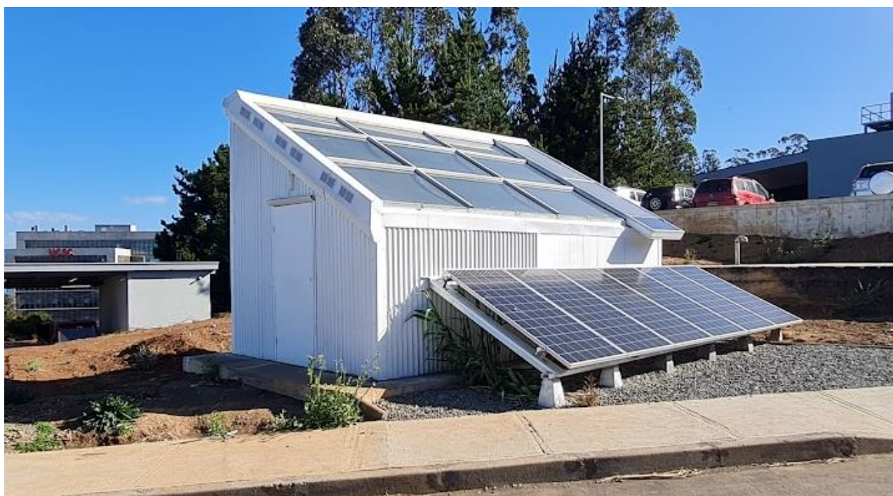
Fig. 4. Vista exterior del edificio laboratorio de secado Geosolar (LSG). Elaboración propia.
