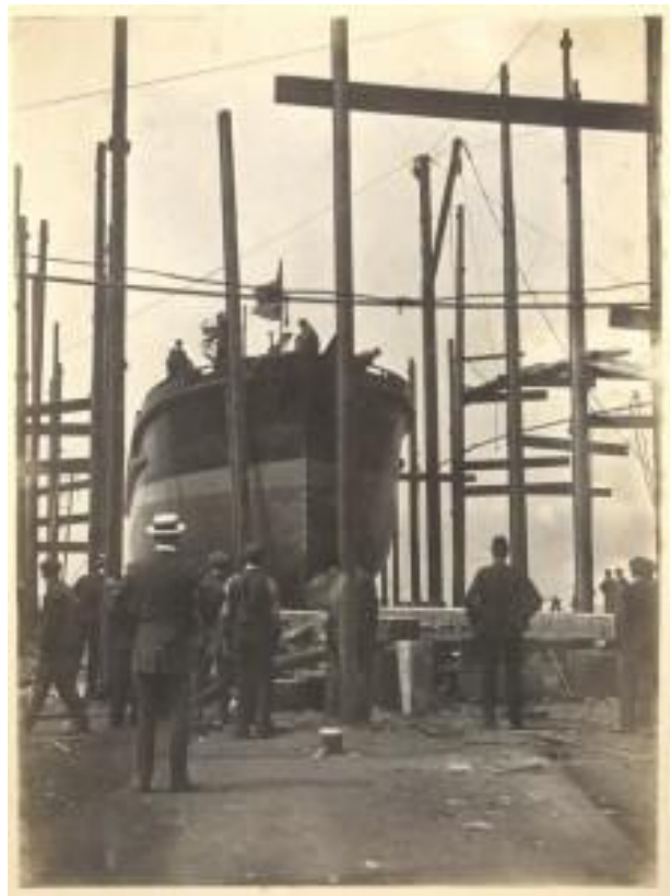
Figura 1.1: Construcción del RAM Poderoso
