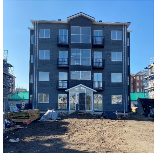
Figura 2: Edificio Horizonte del Pacifico, San Pedro de la Paz Fuente: Elaboración propia.
