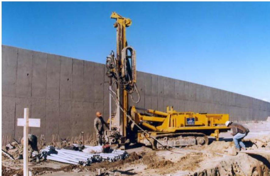
Figura II.16 Ejecución 279 Micropilotes ISCHEBECK 73/53 Long. Entre 6.00 y 9.00 m (Documento Terratest, 2006)
