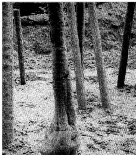
Figura IV.8 Micropilotes excavados (FOREVER, 2008)
