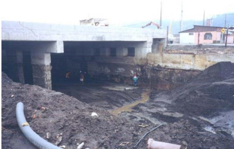
Figura II.19 Etapa de excavación, bajo puente construido, hasta losa del paso inferior con depresión de napa freática (Documento Terratest, 2006)
