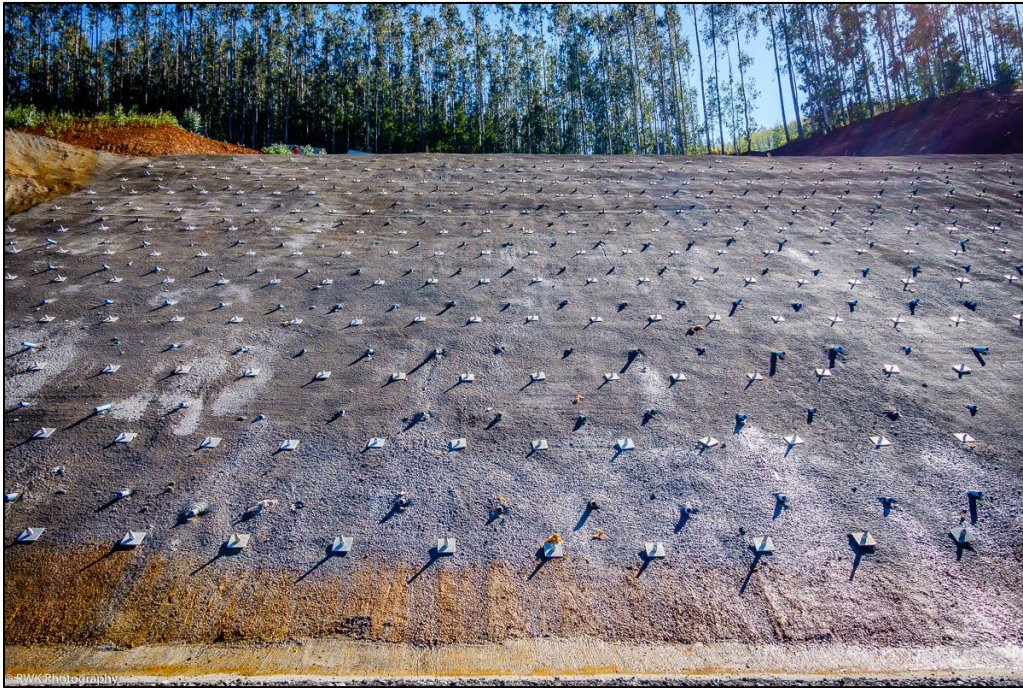
Figura 18: Soil nailing y drenes californianos en los primeros 15m del talud en estudio (Fotografía tomada en Mayo 2017).
