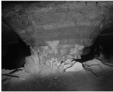
Figura 2: Pilar con una relación original de w/h de 1.7 falló al romperse progresivamente (Esterhuizen et al., 2008).
