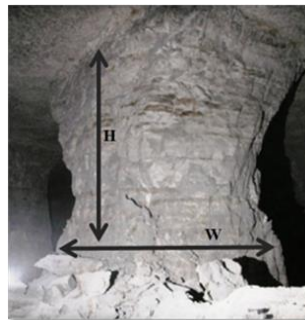
Figura 1: Geometría de un pilar in-situ
