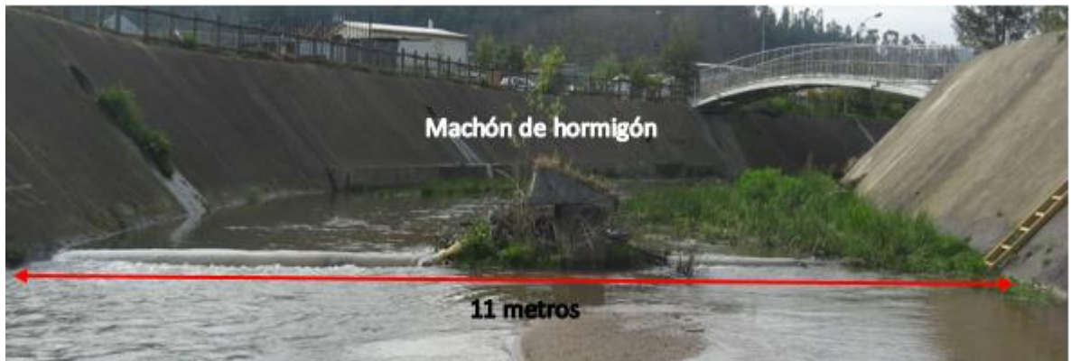
Figura 40. Medida de la tubería. (Fuente: Elaboración propia)
