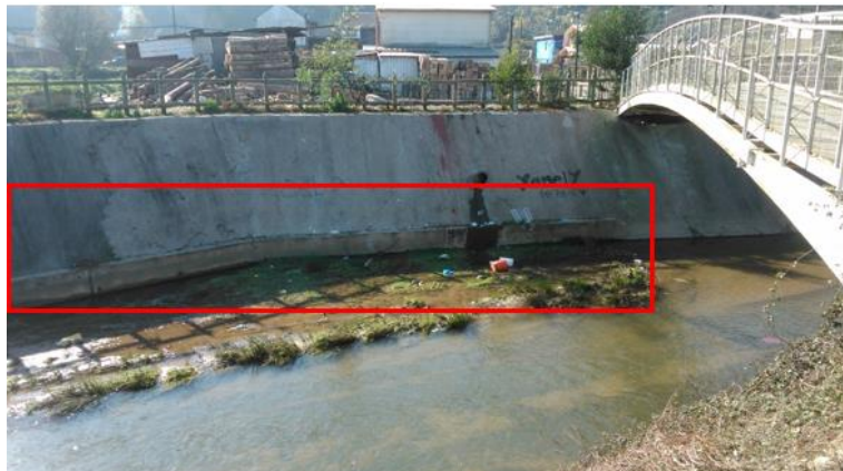
Figura 19. Muro de protección n°2 margen derecho. (Fuente: Elaboración propia).
