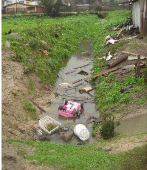
Figura 33. Contaminación canal abierto. (Fuente: Elaboración propia).
