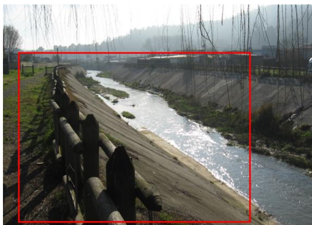
Figura 24. Revestimiento margen izquierdo. (Fuente: Elaboración propia).
