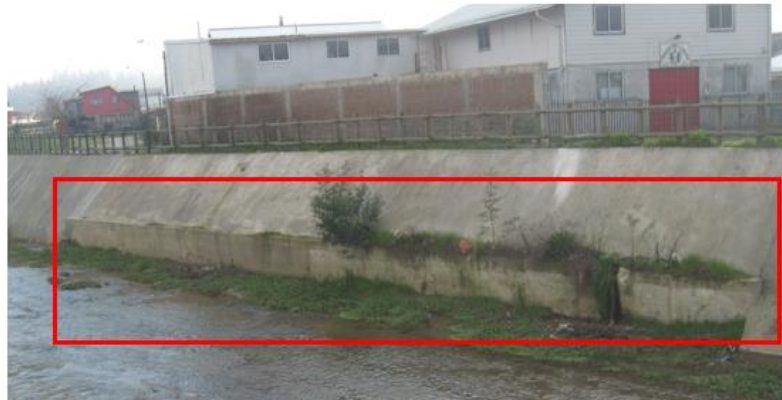
Figura 18. Muro de protección n°1 margen derecho. (Fuente: Elaboración propia).
