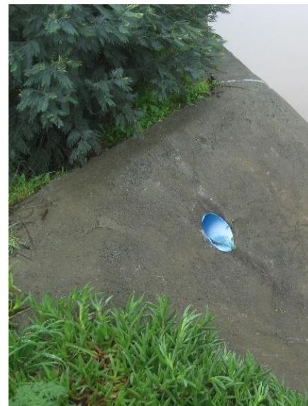
Figura 32. Descarga de agua lluvia residencial. (Fuente: Elaboración propia).
