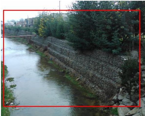
Figura 16. Gaviones margen derecho. (Fuente: Elaboración propia).
