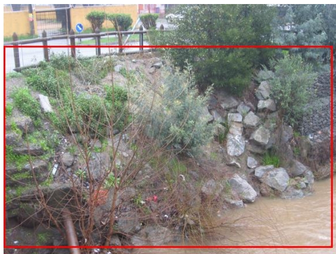
Figura 22. Escollera margen derecho. (Fuente: Elaboración propia).
