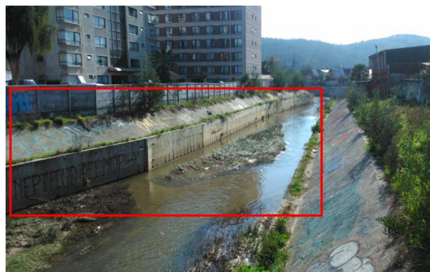
Figura 25. Muro de protección n°1 margen izquierdo. (Fuente: Elaboración propia).
