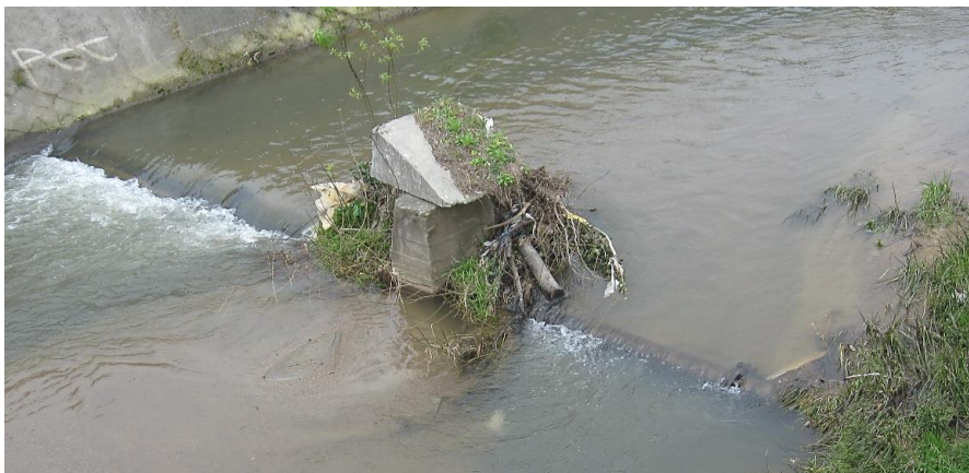
Figura 37. Tubería transversal al canal del Estero Nonguén. (Fuente: Elaboración propia).
