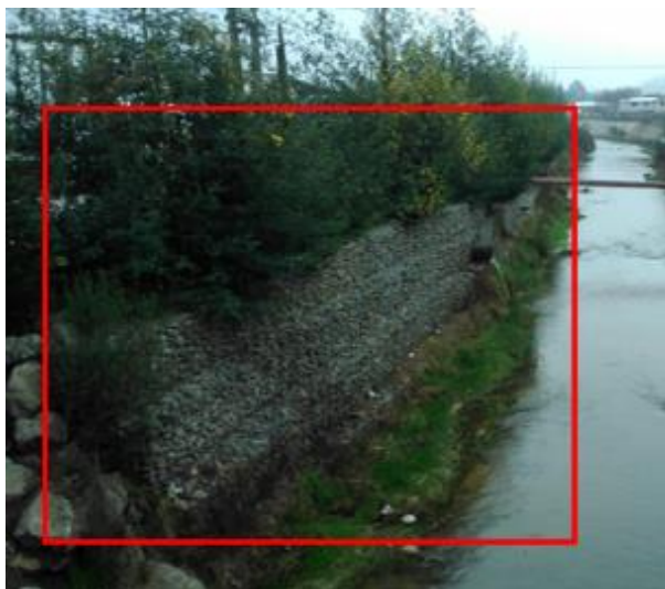
Figura 23. Gaviones margen izquierdo. (Fuente: Elaboración propia).
