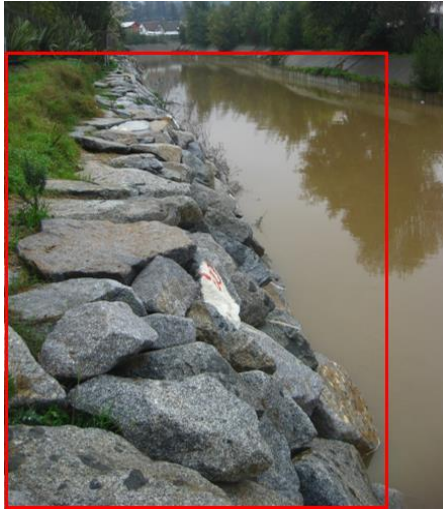
Figura 21. Escollera n°2 margen derecho. (Fuente: Elaboración propia).
