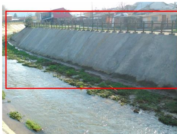
Figura 17. Revestimiento margen derecho. (Fuente: Elaboración propia).
