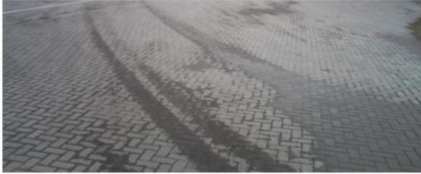
Figura 3. Colocación de adoquines en aparejamiento espina de pescado. (Elaboración propia)
