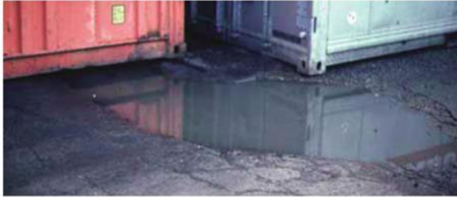
Figura 7. Daño en esquinas por efecto de apilamiento. [7]
