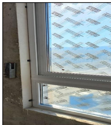
Imagen 8. Ajuste con calzos
