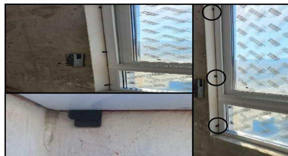
Imagen 15. Ajuste con calzos
