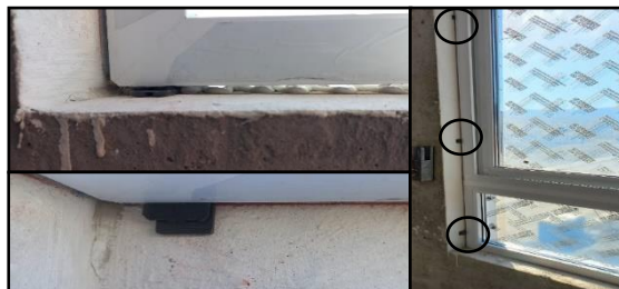
Imagen 26. Ajuste con calzos
