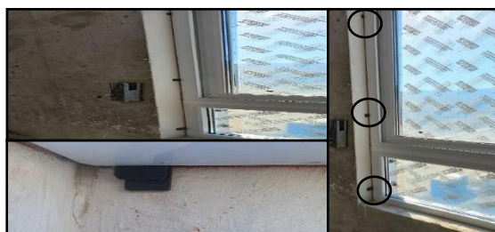
Imagen 42. Ajuste con calzos
