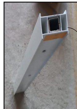
Imagen 49. Sellado de perfil de unión
