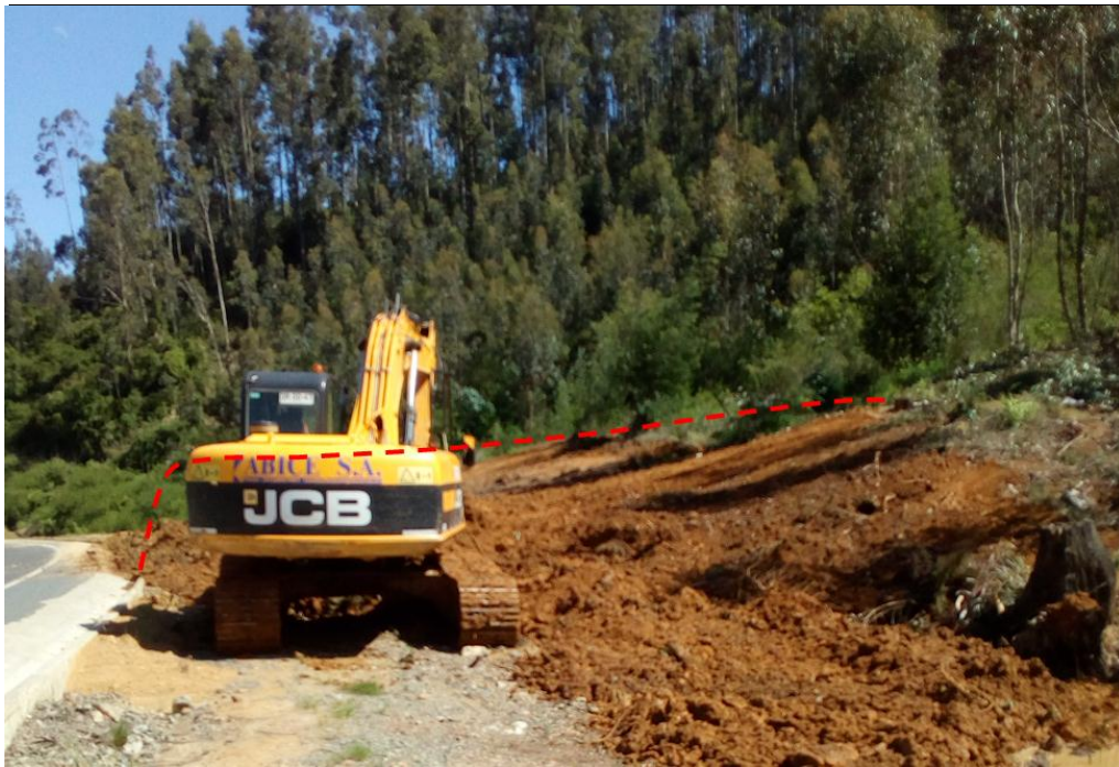
Figura 3: Retiro de material, 10 de noviembre de 2017. En rojo, perfil aproximado del talud antes de retirado el material.
