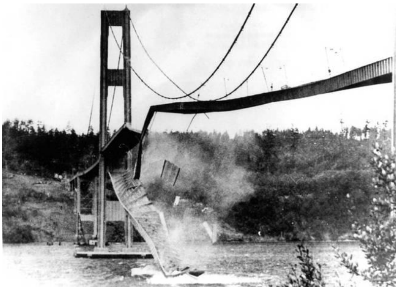
Figura 1. Puente de Tacoma, inestabilidad aeroelástica provocada por flameo.
