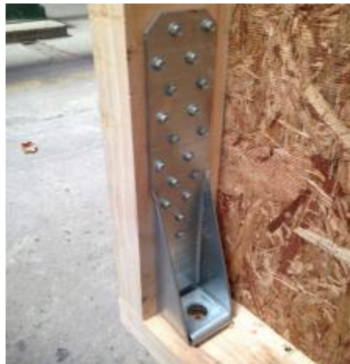
Figura 4.1: Detalle de conectores. Fuente: LME-INFOR.
