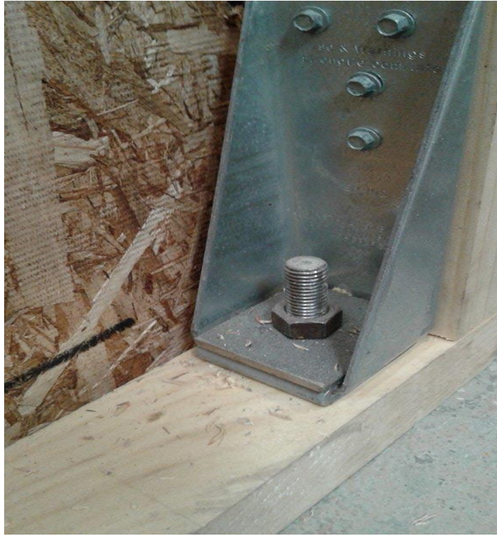
Figura 4.2: Detalle conector-anclaje. Fuente: LME-INFOR.
