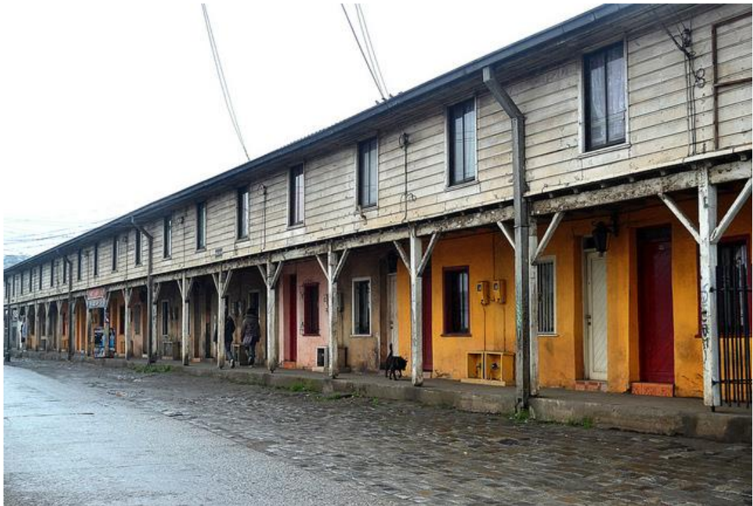
Figura 2.4: Pabellones de Lota, Región del Biobío, construidas en 1915.
