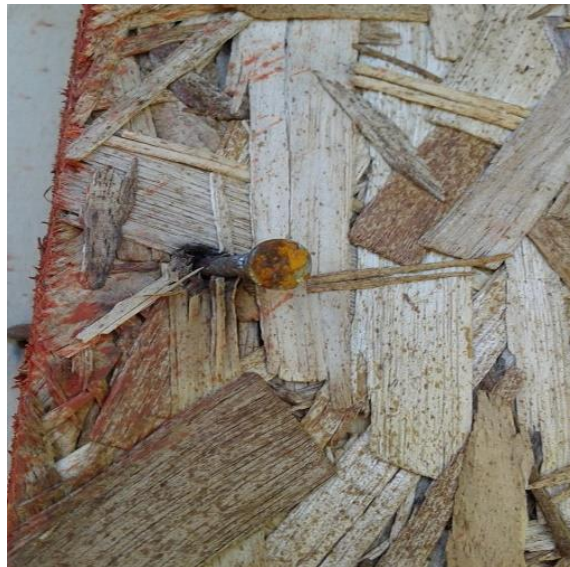
Figura 5.5: Falla por aplastamiento de OSB y fluencia de clavo.
