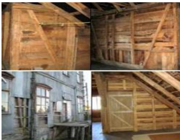
Figura 2.1: Sistemas estructurales en madera de la época 1845-1910. Fuente: [1]
