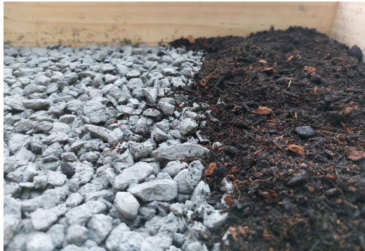
Figura 8. Aplicación de sustrato sobre pastelón de hormigón ecológico.
