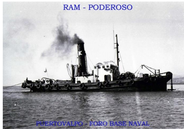
Figura 1.2: RAM Poderoso trabajando en Puerto de Valparaíso.
