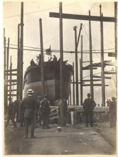
Figura 1.1: Construcción del RAM Poderoso
