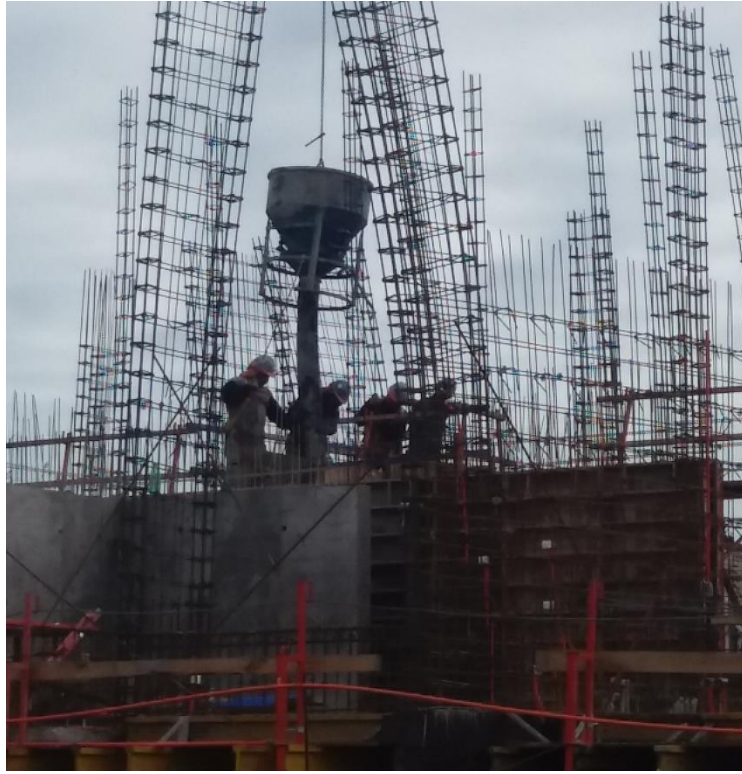
Figura 4.2 Proceso de hormigonado de muros, Torre sur, edificio Nuevo Huertos (Fuente: elaboración propia)
