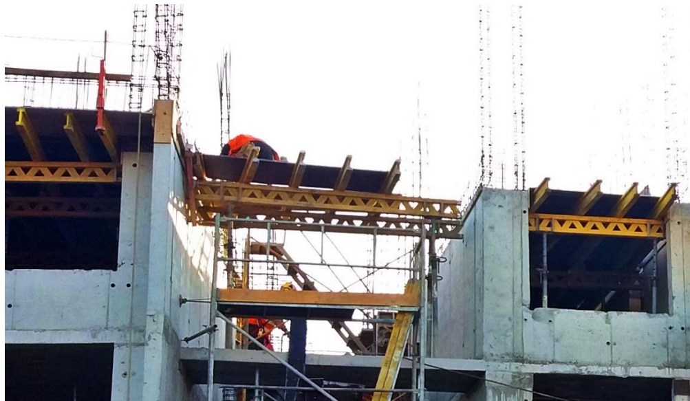
Figura 4.7 Postura de placas fenólicas moldaje de losa, Torre sur, edificio Nuevo Huertos.
