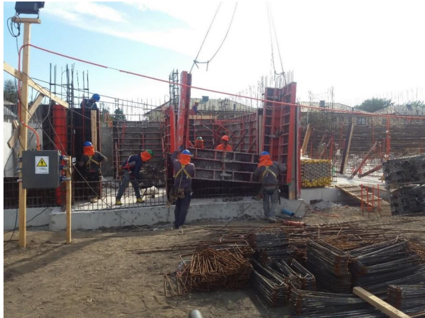
Figura 4.3 Postura de moldaje de muros, Torre sur, edificio Nuevo Huertos (Fuente: elaboración propia)
