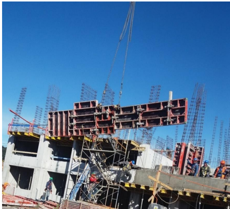
Figura 4.4 Descimbre de muros, Torre sur, edificio Nuevo Huertos (Fuente: elaboración propia)
