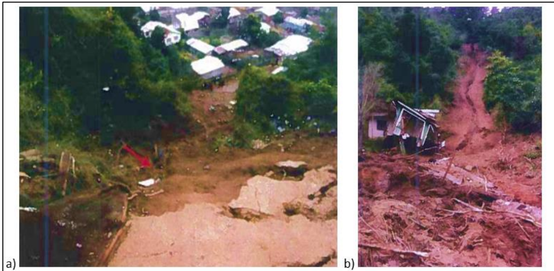
Figura 8: Deslizamiento de tierra en Calle Los Copihues (Punto 5). a) Corona agrietada del deslizamiento en calle Los Copihues. b) Casa destruida por el movimiento en masa. Imágenes extraídas de Naranjo et al. ,2006.
