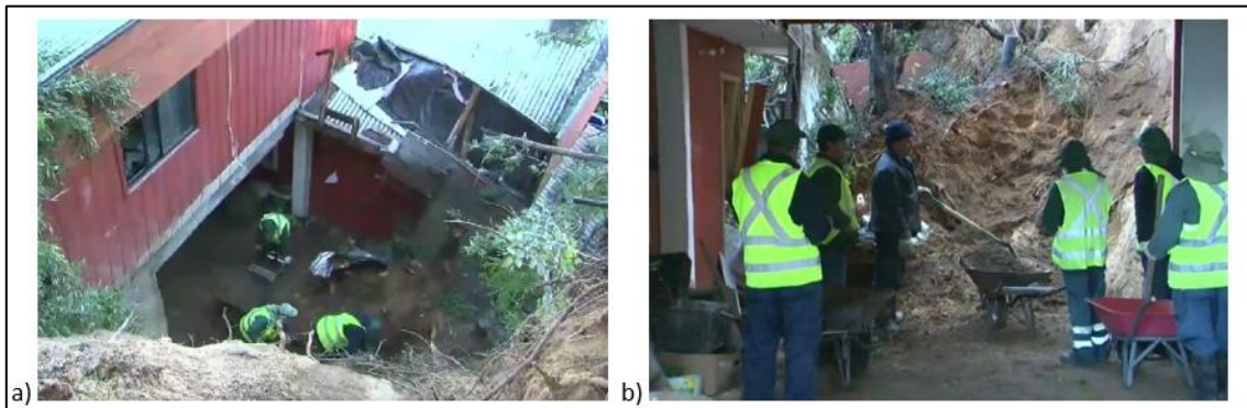
Figura 7: a) Vivienda afectada por la remoción en masa del 18 de Julio del 2022. b) Vista de remoción en masa desde el interior de la vivienda. Imágenes extraídas del sitio web de la Municipalidad de Chiguayante.
