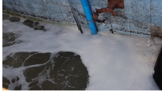
Fotografía 2. Canal de Efluente, PTAS Castro.
