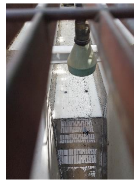
Fotografía 6. Canal acercamiento Parshall de Afluente post extensión y angostamiento, PTAS Río Negro.
