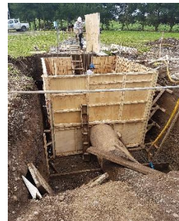
Fotografía 3. Proceso de construcción cámara de contrastación, PTAS Osorno.
