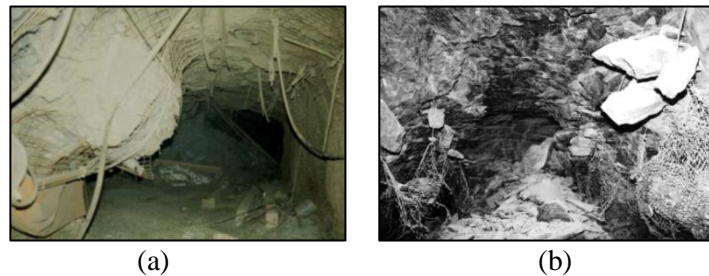
Figura 4: Casos de estallidos de roca en minas canadienses con distintos resultados. (a) Bulking y (b) Eyección de roca resultando en bloqueo total de la galería (Fuente: Kaiser et al., 1996).
