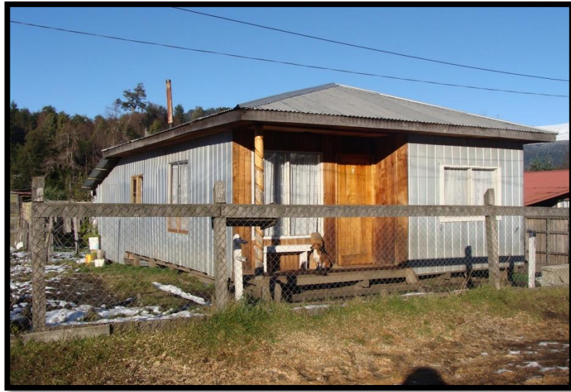
Figura 34. Vivienda situación actual sin baño
