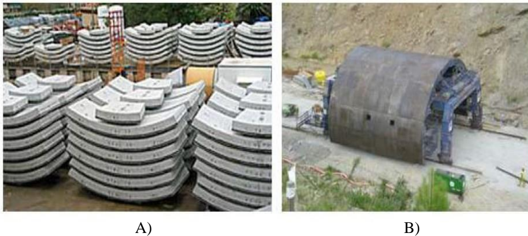
Figura 4: Dovelas pre-fabricadas. A) Espacio dispuesto para el almacenamiento de elementos prefabricados previo a su ubicación final en el contorno del túnel y B) Cabezote de la TBM (Echeverría, 2013).
