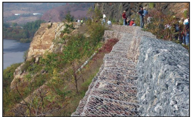
Figura 5.D. Gaviones instalados al costado de una carretera. (Highland y Bobrowsky, 2008).
