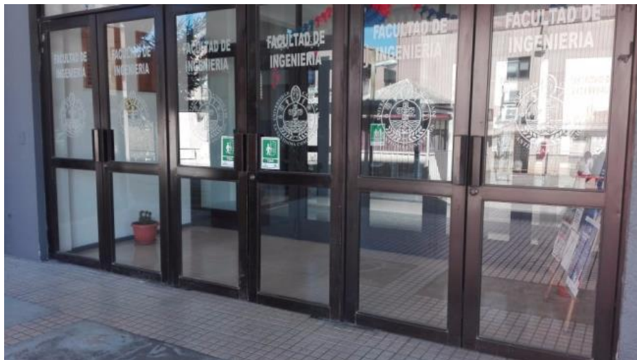
Ilustración 10.- Mampara de ejemplo, Facultad de Ingeniería Fuente propia
