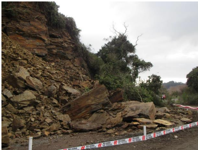
Figura 2: Remoción en masa por volcamiento en Parque Pedro del Río Zañartu, comuna de Hualpén, Región del Biobío. (SERNAGEOMIN, 2019)
