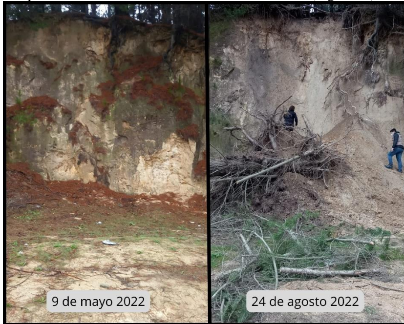
Figura 12: Desprendimiento de roca suelo ruta O-478 Ramuncho Hualpén. (Gentileza de Miguel Abarzúa, Sebastián Antinao & Gonzalo Peña, 2022).
