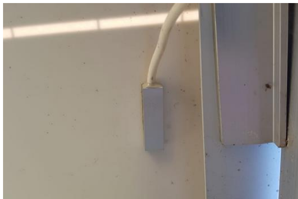
Figura 2.36 Sensor de temperatura adhesivo PT1000 (vista posterior)
