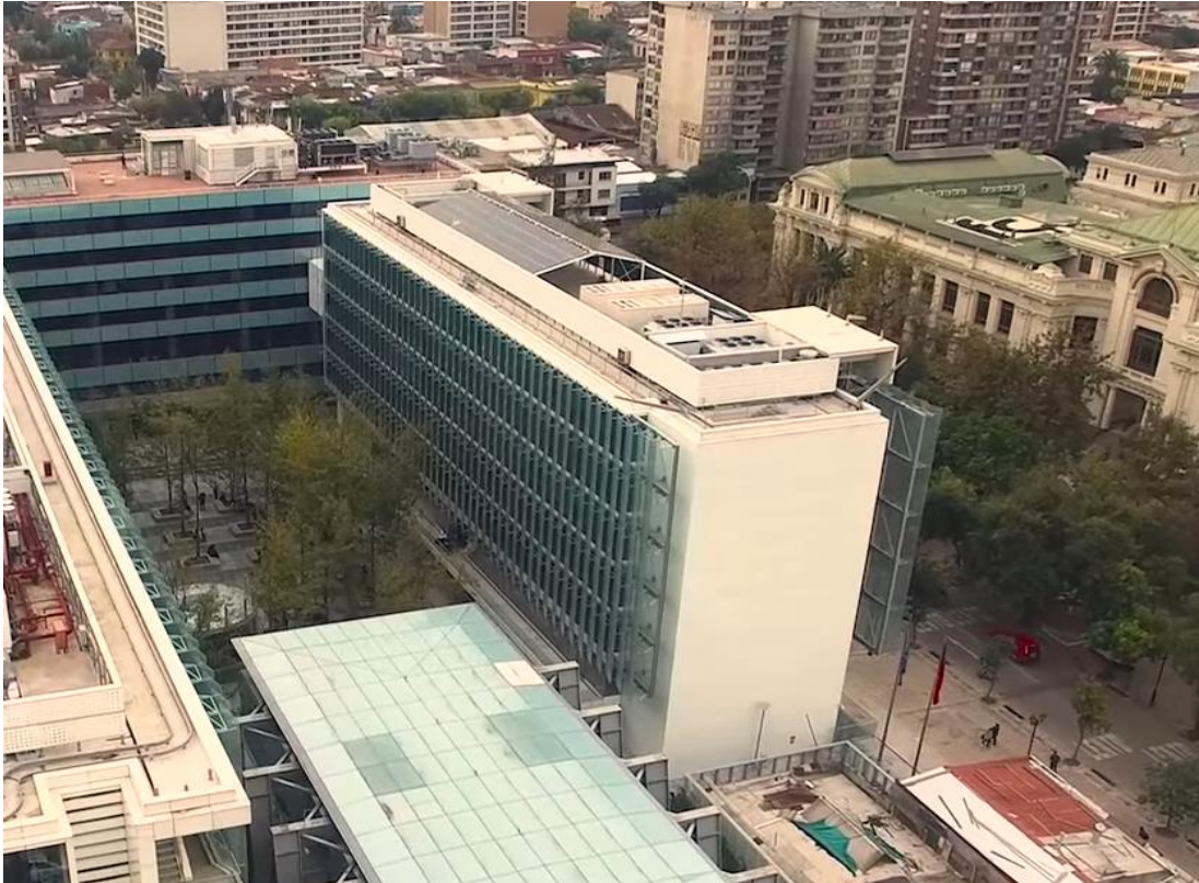
Figura 1.10 Vista superior de Terraza solar Universidad de Chile
