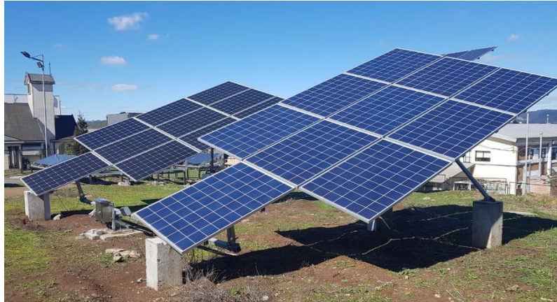
Figura 2.19 Sistema de seguimiento solar un eje Inclinado
