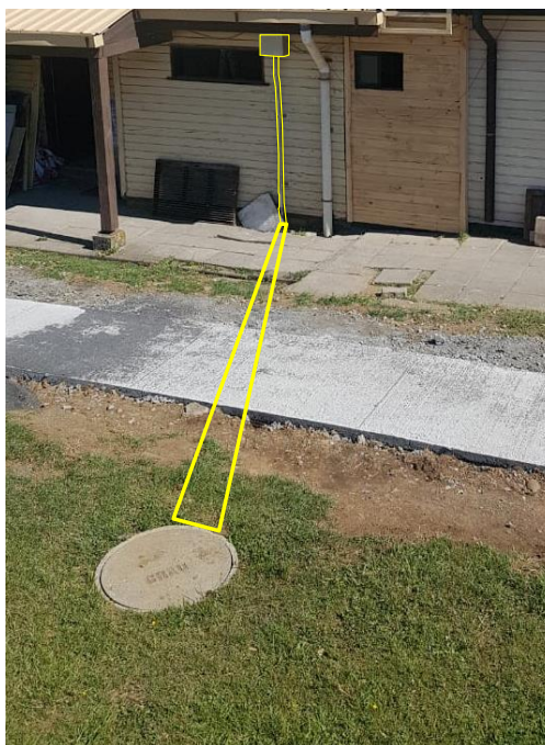
Figura 2.5 Seguimiento canalización y Cámara subterránea (2)
