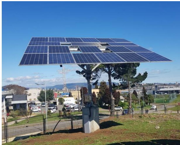
Figura 2.18 Sistema de seguimiento Monoposte (dos ejes)
