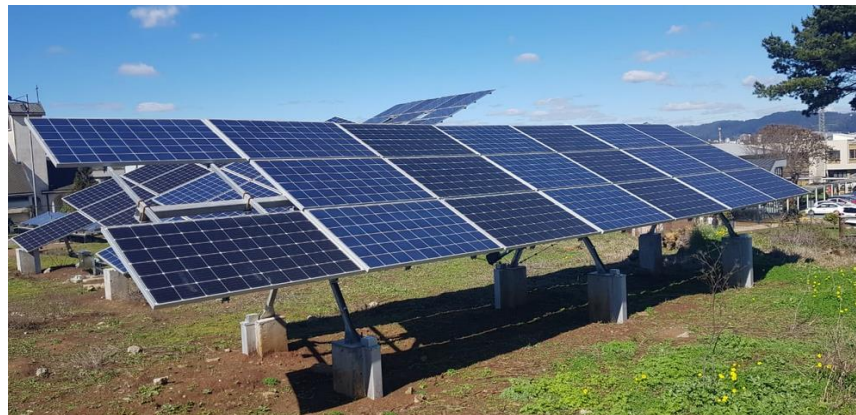
Figura 2.20 Sistema de seguimiento 1 eje horizontal.
