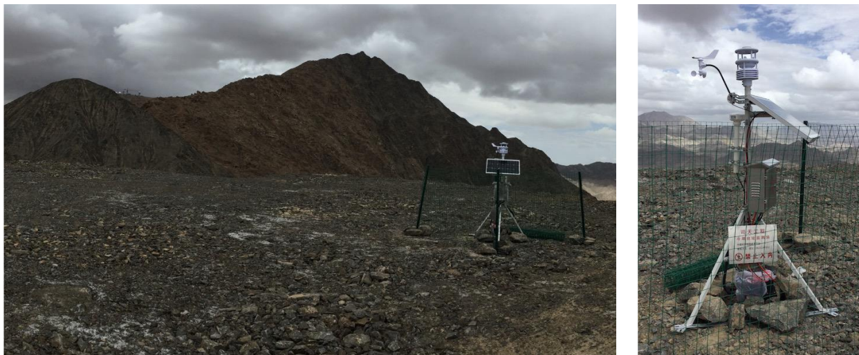
Fig. 2.8. Sistema de alimentación, Estación Lenghu, China. Fuente: Shang, Z. (2023). Annual Report, Grant No. CCJRF2101.
