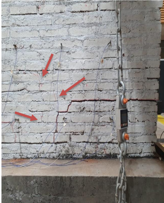
Figura 33: Nuevas grietas en el proceso de extensión del actuador, en desplazamiento de 16 (mm) (Fuente: Elaboración propia)
