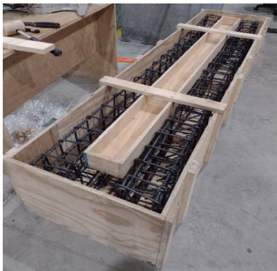
Figura 1: Moldaje y armadura para fundación (Fuente: Elaboración propia)
