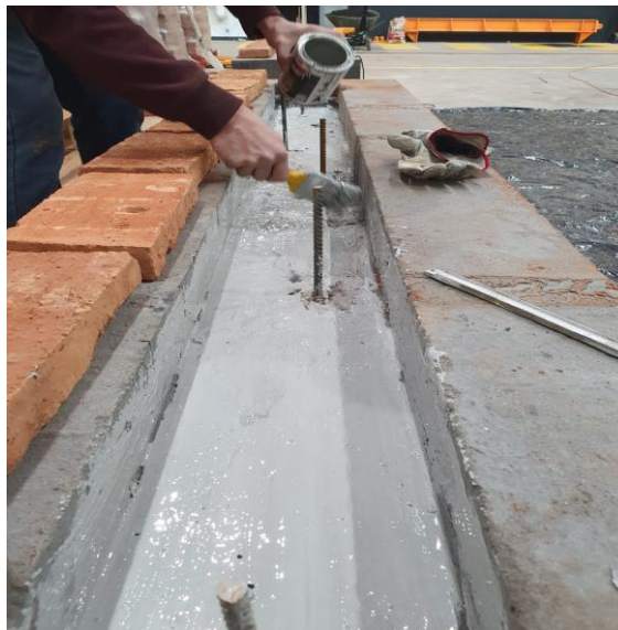
Figura 4: Distribución del puente adherente en las paredes y base del surco (Fuente: Elaboración propia)
