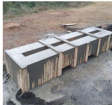
Figura 2: Moldaje recién hormigonado (Fuente: Elaboración propia)
