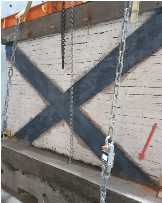
Figura 19: Registro general de muro de albañilería, de grieta a los 6 (mm) (Fuente: Elaboración propia)
