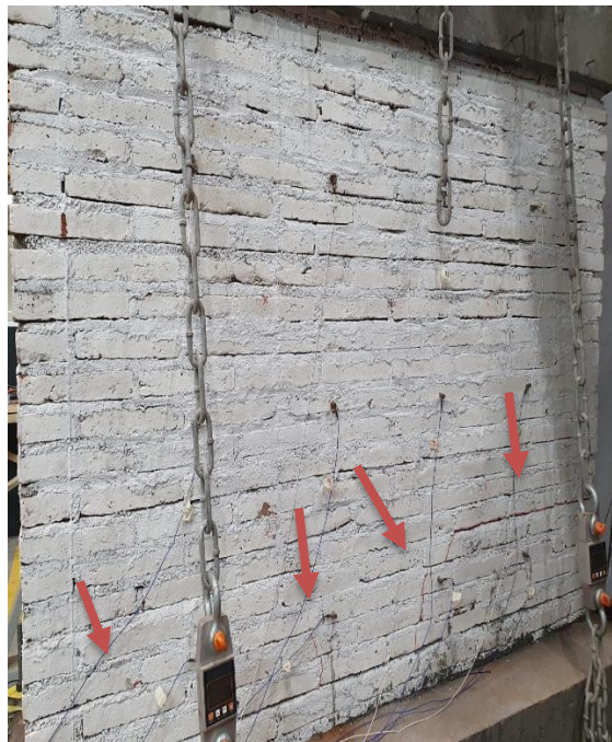
Figura 22: Múltiples grietas en la parte posterior del muro de albañilería (Fuente: Elaboración propia)
