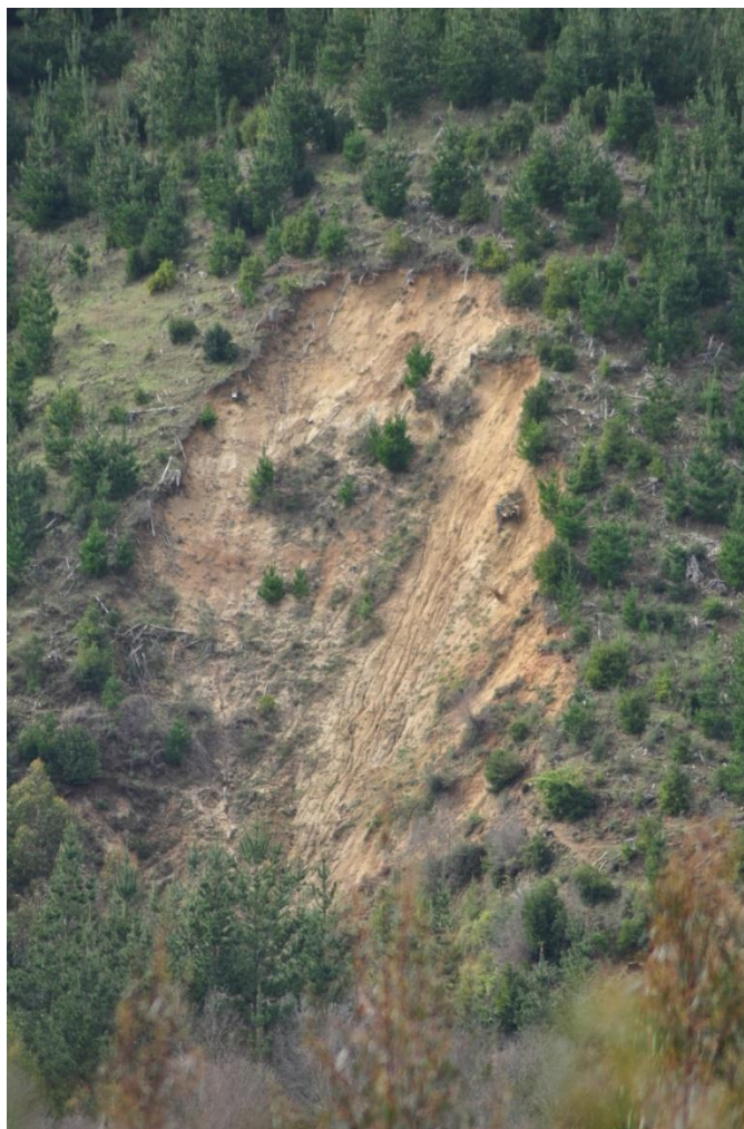
Figura 4.37 Deslizamiento en las cercanías al Camino 30 Parcelas Cabrerías.
