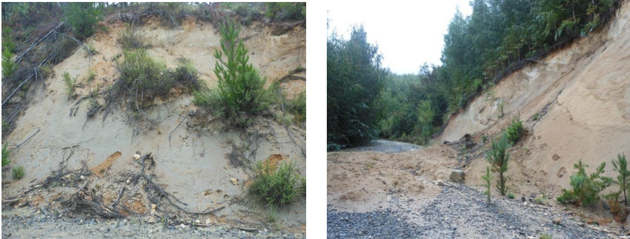
Figura 3.6 Taludes en Fundos Trongol (F-1) y Caballo de palo (F-2)
