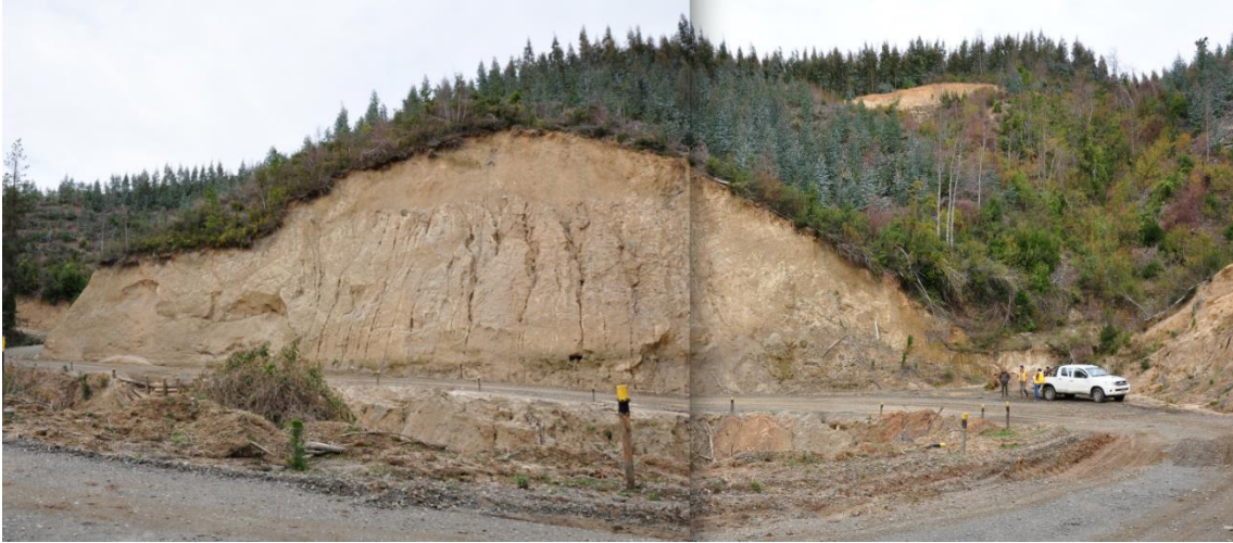
Figura 4.38 Talud Camino 18 Parcelas Cabrerias
