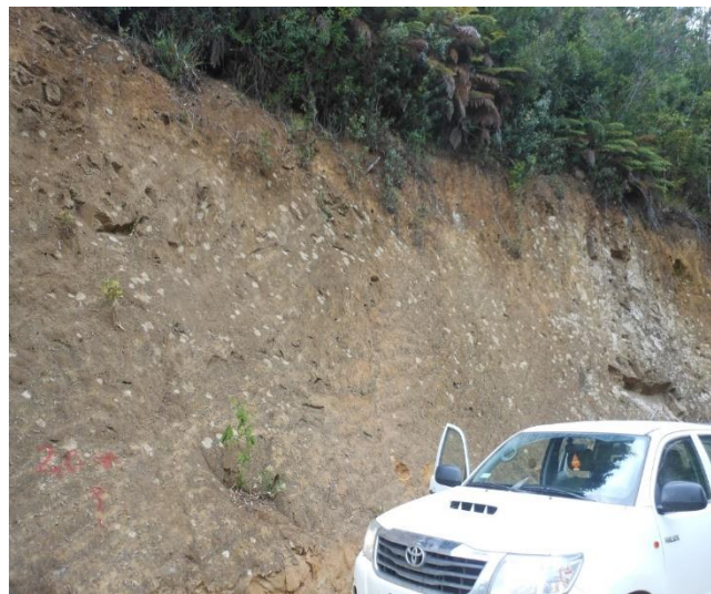
Figura 3.9 Talud en Fundo Alto molul y otros (F-8)
