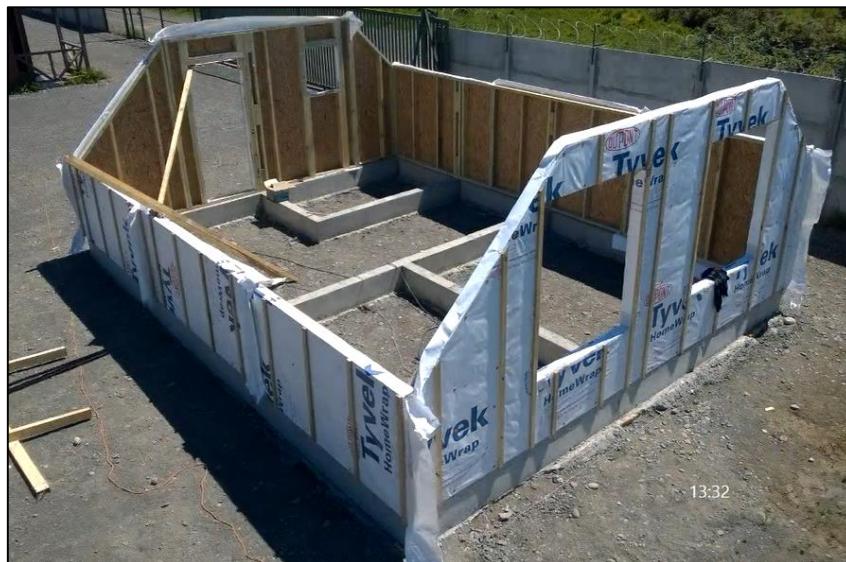
Figura 16. Estructura Panel Prefabricado Compatible. Fuente: Empresa Compatible.
