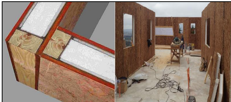
Figura 1. Panel estructural de OSB y poliestireno expandido de alta densidad. Fuente: Tecno Panel.
