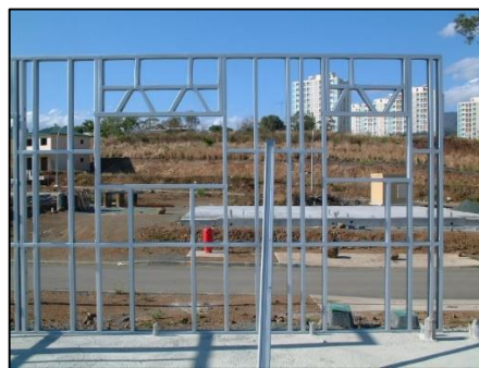
Figura 12. Panel Prefabricado de Metalcon.- Fuente: Tecno Panel.
