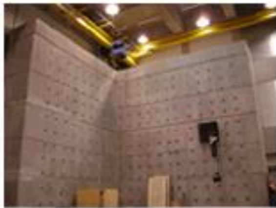
Figura 2.5: Muro de Reacción – Universidad de los Andes.
