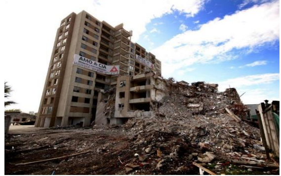
Figura 2.6: Edificio Plaza del Río, Concepción. (Terremoto 2010) (Fuente http://www.emol.com )
