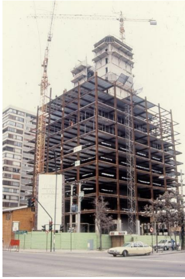
Figura 2.13: Construcción Torre las Condes (1992), Santiago. (Fuente: http://www.liraarquitectos.cl )
