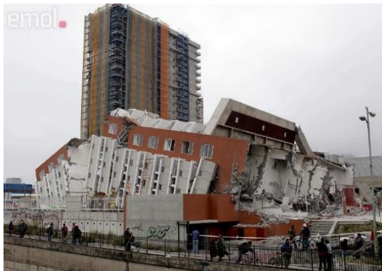
Figura 2.7: Colapso Edificio Alto Río, Concepción. (Terremoto 2010) (Fuente http://www.emol.com )
