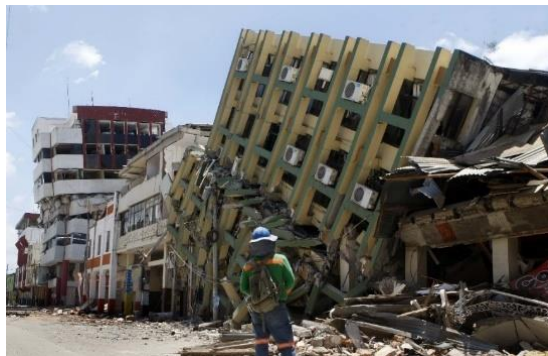
Figura 2.1: Edificios colapsados en Portoviejo, Ecuador Terremoto 2016.
