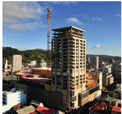
Figura 2.10: Construcción Torre del Centro (2013), Concepción. (Fuente: http://torredelcentro.cl )
