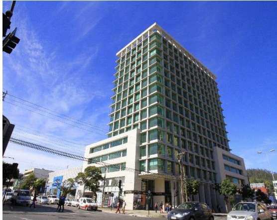
Figura 2.11: Edificio Neocentro, Concepción. (Fuente: http://www.portalinmobiliario.com )
