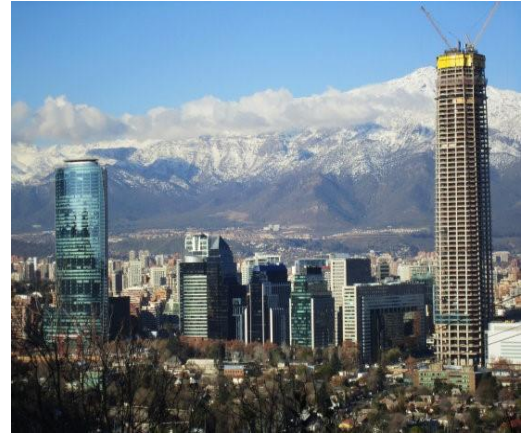
Figura 2.12: Edificios Titanium (Izquierda) y Costanera Center Cencosud (Derecha), Providencia. (Fuente: http://www.latercera.com )
