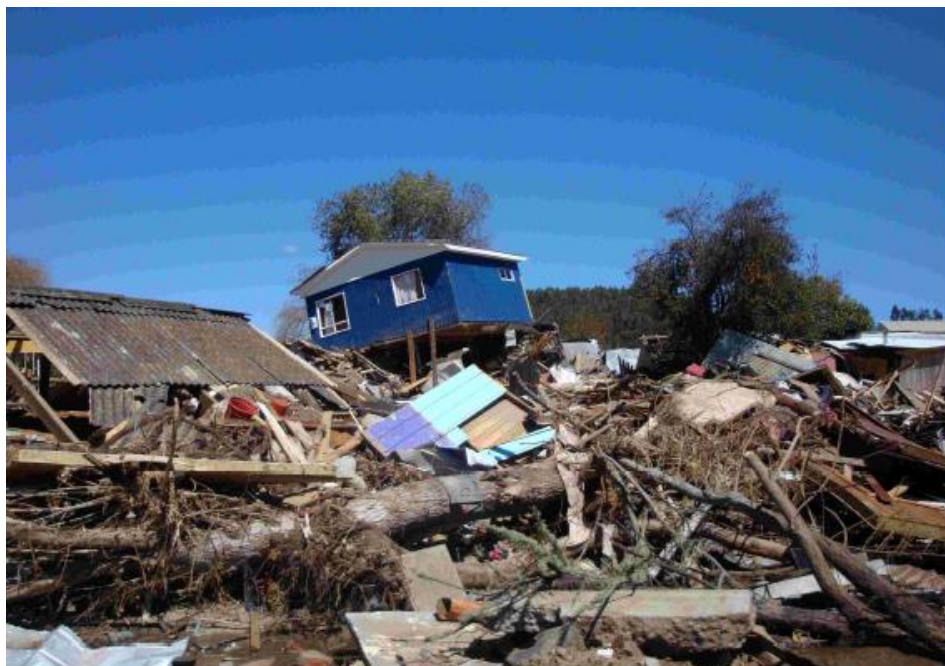
Figura 3.5: Sector afectado por tsunami de 27 de febrero en Dichato. Fuente: SERNAGEOMIN
