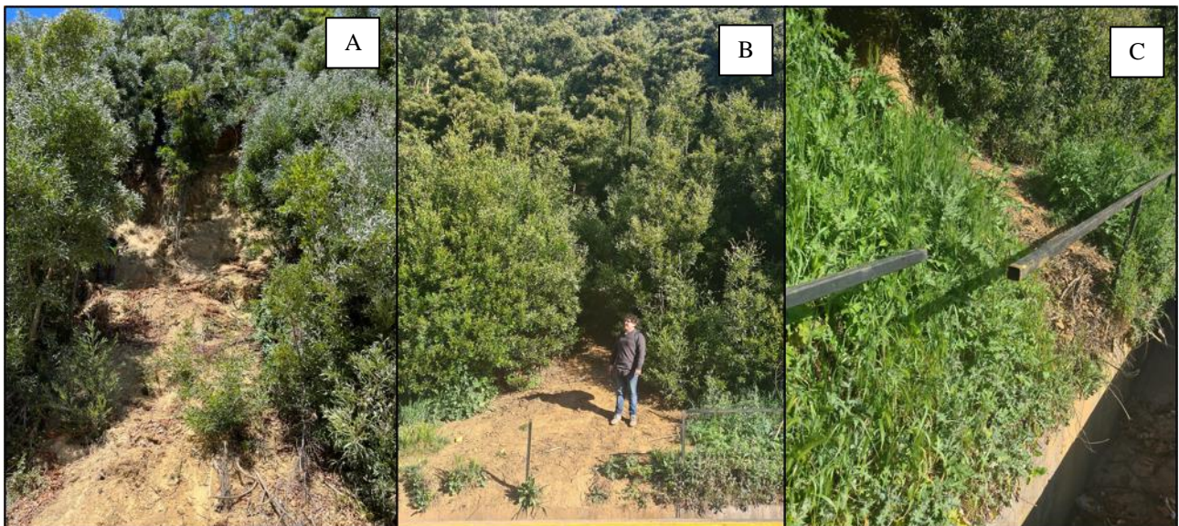
Figura 13: A) Vegetación en Talud 7. B) Vegetación en Talud 8. C) Vegetación en Talud 10. Elaboración propia (2022).
