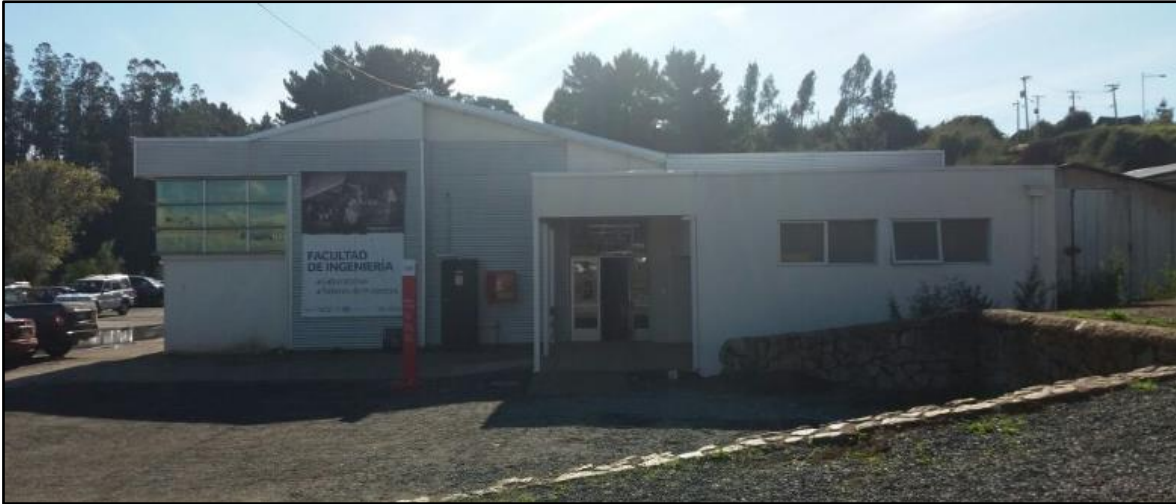
Imagen N°35: Vista frontal del laboratorio de ingeniería terminado. Fuente: Elaboración propia.
