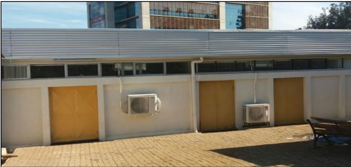
Imagen N°36: Vista lateral del laboratorio de ingeniería terminado. Fuente: Elaboración propia.
