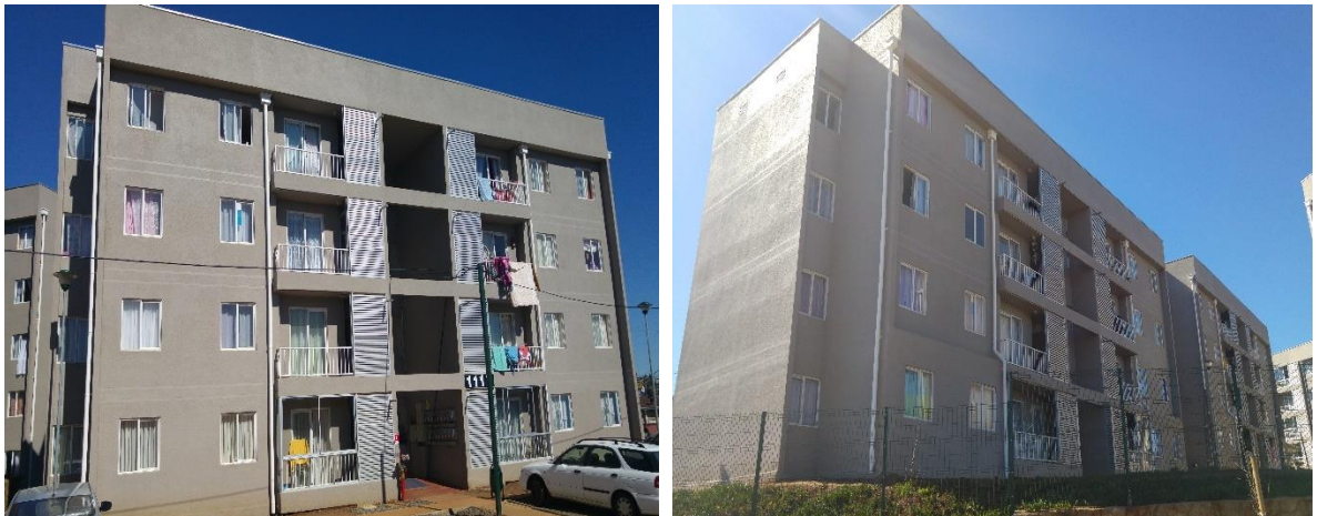
Figura 5.1: Vista Anterior y Posterior de Edificio Lord Cochrane, Tomé
