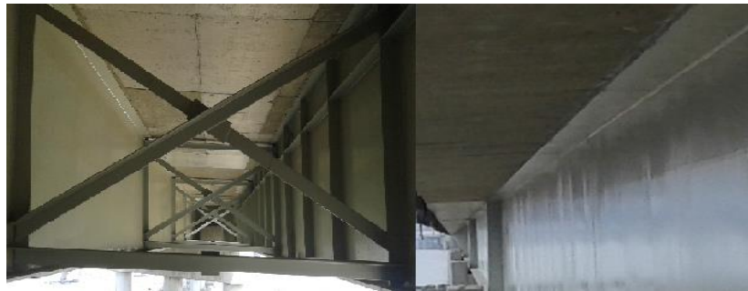
Figura 3.2: Tablero apoyado sobre viga de acero.
