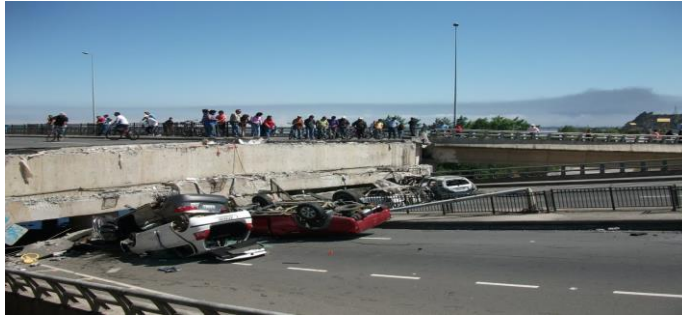
Figura 2.6: Falla Tablero Puente Llacolén, sismo 27 de febrero 2010. (Fuente: am-sur.cl).
