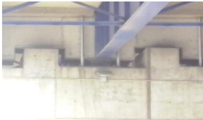
Figura 2.14: Apoyos de neopreno en Paso de nivel Avenida Jorge Alessandri.
