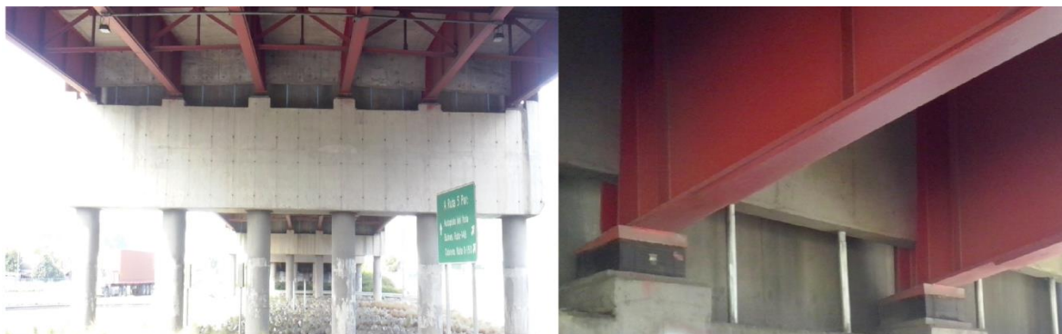
Figura 2.15: Apoyos de neopreno y barras antisísmicas pasó nivel rotonda General Bonilla.
