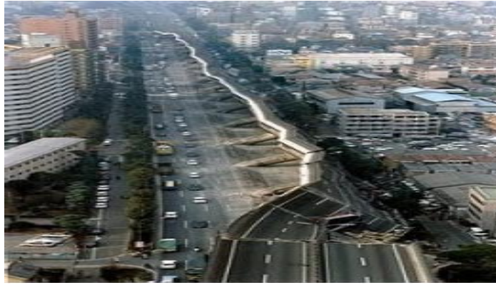
Figura 2.1: Colapso de puente durante sismo Kobe, Japón 1995. (Fuente: [3]).
