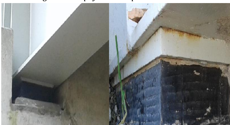
Figura 3.4: Apoyos de neopreno en Estribos.
