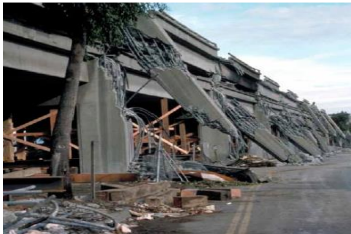
Figura 2.2 Colapso de puente vehicular Oakland, California sismo Loma Prieta 1989. (Fuente: [3]).
