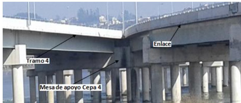
Figura 3.8: Conexión de enlace y tramo 3 del puente en Ceba 4.
