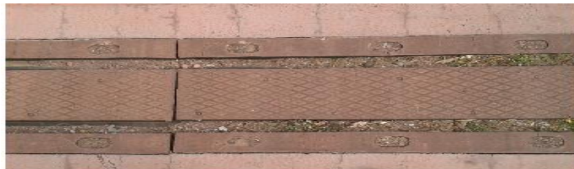
Figura 3.2: Tablero apoyado sobre viga de acero.
