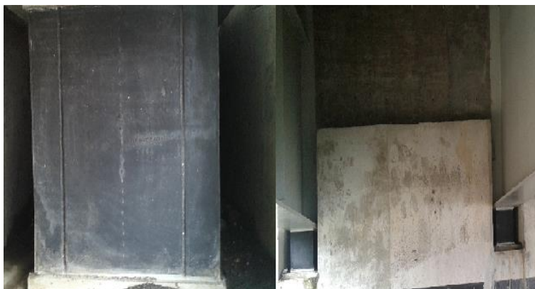
Figura 3.4: Apoyos de neopreno en Estribos.
