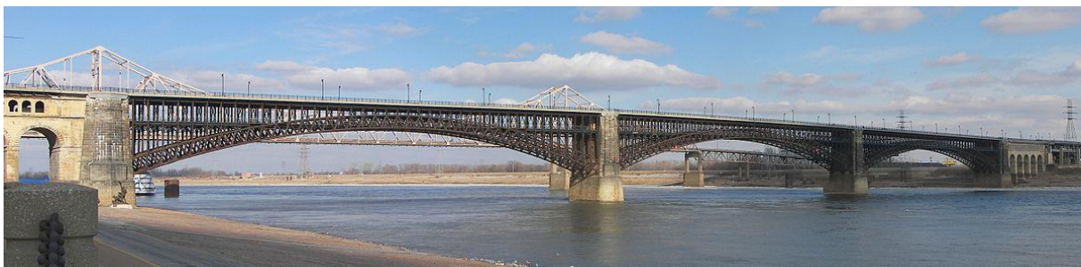
Figura 2: Extensión del Puente Eads, sobre el Río Misisipi, longitud del puente: 1964m.
