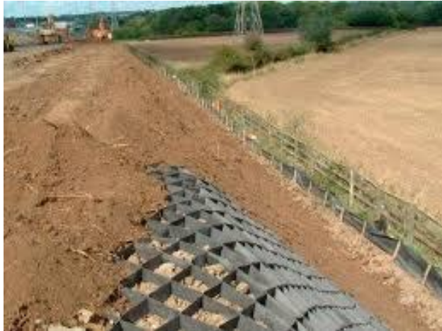
Figura 2.6: Geocelda rellena con material cohesivo (Tensar International Corporation).
