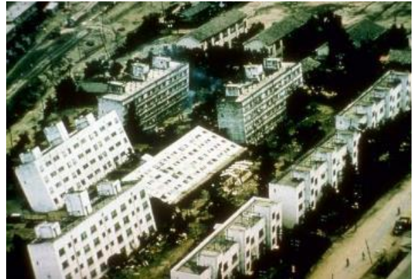
Figura 2.30: Edificio de departamentos volcados por pérdida de resistencia del suelo de fundación, debido al efecto de licuación producido por el terremoto de Niigata de 1964 (Kramer, 1996).
