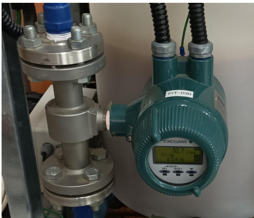
Fig. A-3. Sensor de caudal magnético Yokogawa ADMAG modelo AXF025G.
