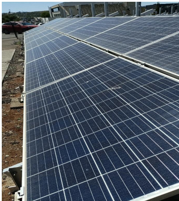
Fig. 2-2. Paneles solares policristalinos (JINKO JKM270PP-60) utilizados en el proyecto.
