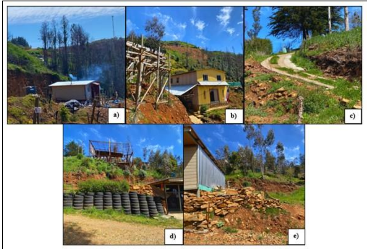
Figura 18: Intervención antrópica en la Ladera Este a) Talud con altura de 2m excavado para instalación de vivienda. b) Vivienda construida al pie de ladera y estructura emplazada en terreno en desnivel. c) Camino para tránsito vehicular. d) Construcción de muro con neumáticos e) Construcción de muro de mampostería con bloques de roca metamórfica local. (Elaboración propia).
