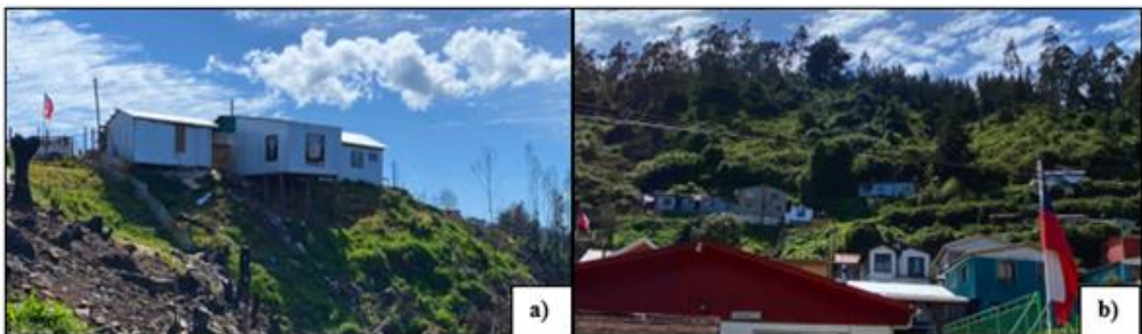
Figura 17: a) Vivienda construida en pilotes de madera en la Ladera Sureste. b) Viviendas construidas en la Ladera Suroeste. (Elaboración propia).
