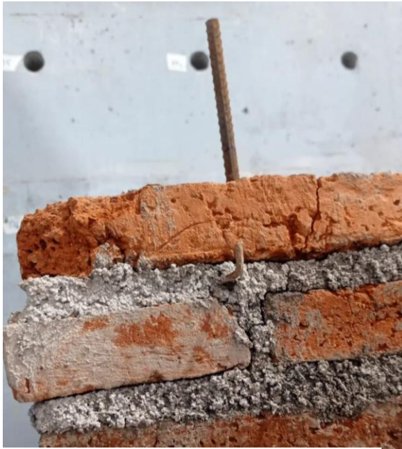
Figura 7: Ruptura en esquina superior del muro debido a espiga (Fuente: Elaboración propia)
