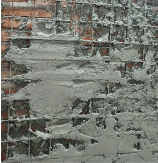
Figura 9: Proceso de estucado sobre malla electrosoldada (Fuente: Elaboración propia).
