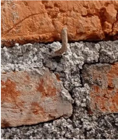
Figura 4: Ganchos de malla electrosoldada (Fuente: Elaboración)
