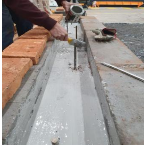
Figura 3: Aplicación puente adherente en surco de fundación (Fuente: Elaboración propia)
