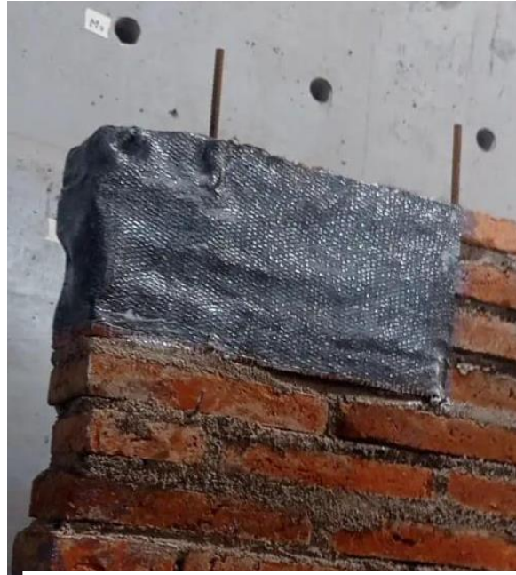
Figura 8: Esquina reforzada con CFRP (Fuente: Elaboración propia)
