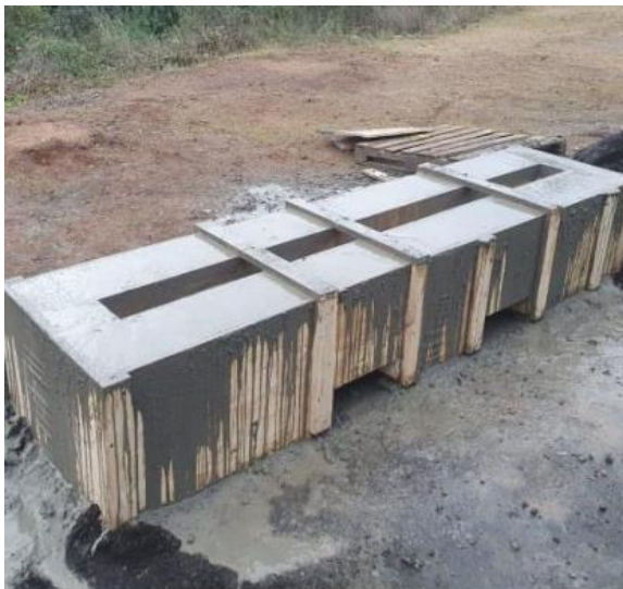
Figura 1: Moldaje recién hormigonado (Fuente: Elaboración propia)
