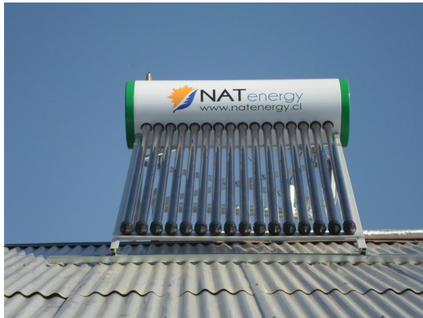
Figura 21. Colector solar Heat Pipe con acumulador incorporado de 150 L.
