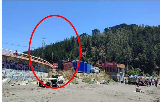
Figura 6: Fin del muro Costero en Caleta Lengua
