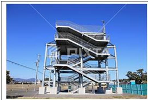
Figura 24. (a): Torre ahora evacuación vertical en Prefectura Shizuoka, Japón. Fuente: https://www.pixtastock.com/photo/20700290
