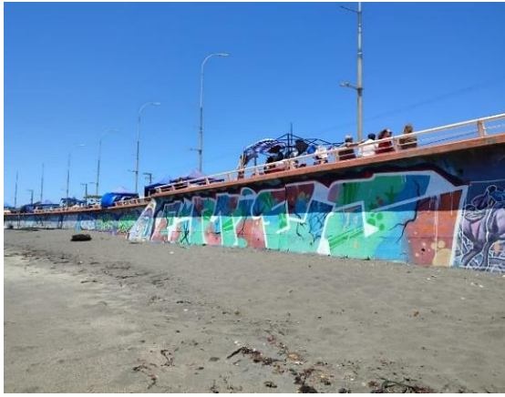
Figura 5: Muro costero de Caleta Lengua
