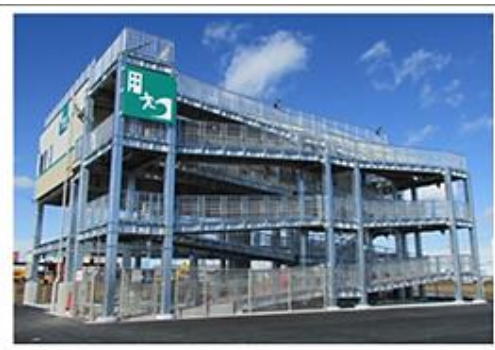
Figura 24. (b): Estructura de evacuación vertical de tsunami en Sendai, Miyagi, Japón. Fuente: https://www.pixtastock.com/photo/20700290
