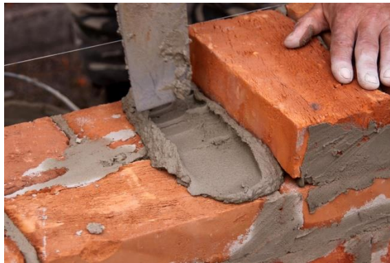
Figura 4. Mortero de pega en albañilería.
