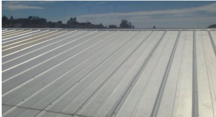
Ilustración 10: Estado real del exterior del techo tipo 1. Fuente : Elaboracion propia
