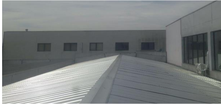
Ilustración 12: Estado real del exterior del techo tipo 2. Fuente : Elaboracion propia
