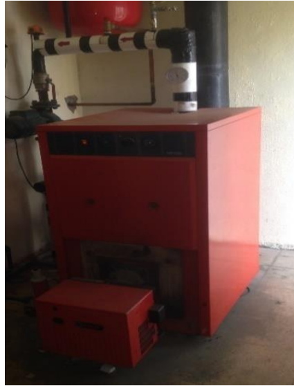
Ilustración 16: Caldera marca SIME, modelo, AR4. Fuente: Elaboración propia.
