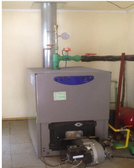
Ilustración 15: Caldera marca SIME, modelo, 2R7 of. Fuente: Elaboración propia.
